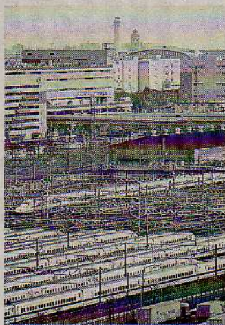
羽田空港の管制塔（奥）をのぞむJR東海の大井車両基地（東京都品川区）
